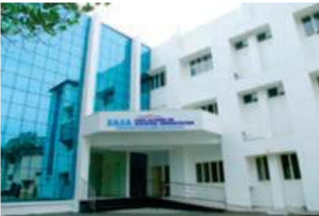
डीईएसएम एंड ई मुख्यालय भवन, सिक्कम
